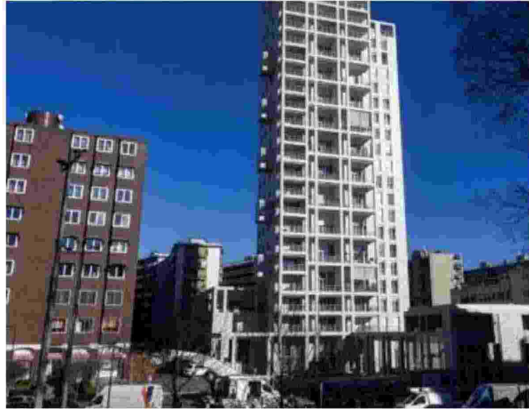
Torre Milano di via Stresa: permesso di costruire in altezza 82 metri nel mirino dei pm
