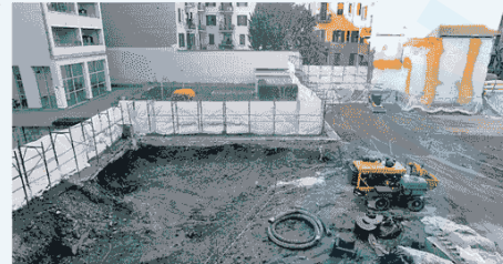
▲ Via Lepontina Un edificio di due piani demolito per fare posto a un palazzo di 22 metri: il cantiere è stato fermato
