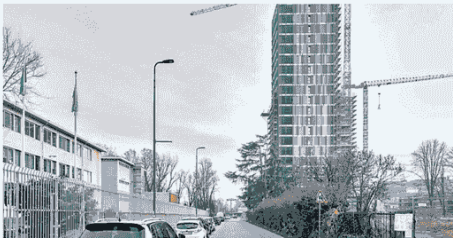
▲ Via Crescenzago Le due torri in costruzioni sono finite in un'inchiesta per presunto abuso edilizio
