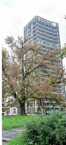
▲ Le Park Towers Sono uno dei progetti nel mirino della procura e attualmente fermo
