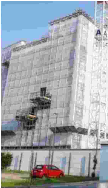
Il cantiere in via Cancano 5 è sotto sequestro da luglio
