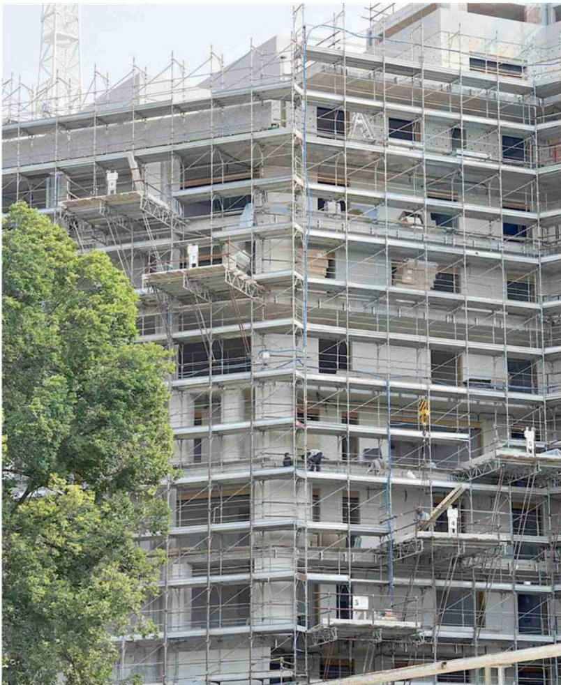
Il cantiere Bosconavigli in piazzale delle Milizie sotto indagine
