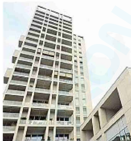
Cantieri La Torre Milano sorta in via Stresa
