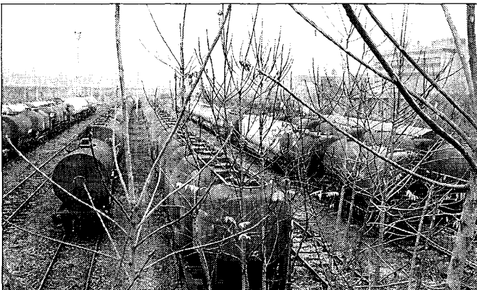
Lo scalo ferroviario di via Isonzo. Le Ferrovie hanno proposto al Comune di utilizzare le aree dismesse in cambio di un rilancio della seconda linea del Passante
