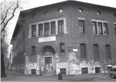
Edificio in piazza pesantemente imbrattato
