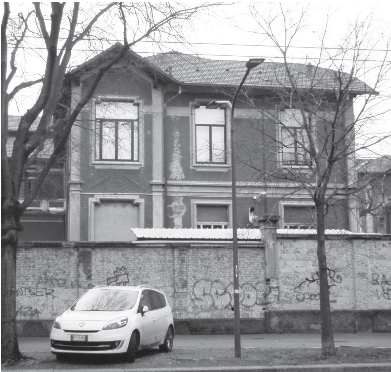
Palazzina di via Ponzio 11, due piani con ampie macchie di infiltrazioni d'acqua brutta tettoia in ondulux muro di cinta scrostato e vandalizzato
